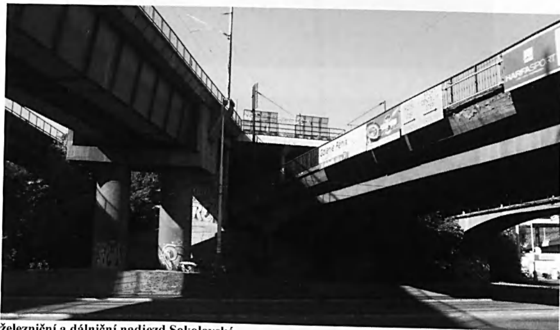
železniční a dálniční nadjezd Sokolovská
