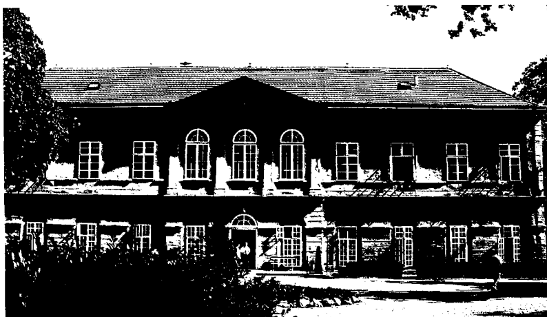
75) Jinošov – vstupní průčelí ( foto B. Brožek)
