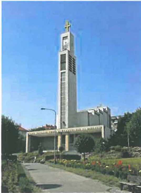
Obr. č. 4.6: Kostel Sv. Václava v Praze Vršovicích
