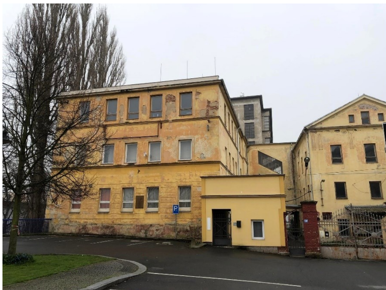
Obr. 5 – Pohled na Steinovu továrnu, v blízkosti paláce rodiny Steinů, areál Na Dubovci (vlastní archiv autorky)
