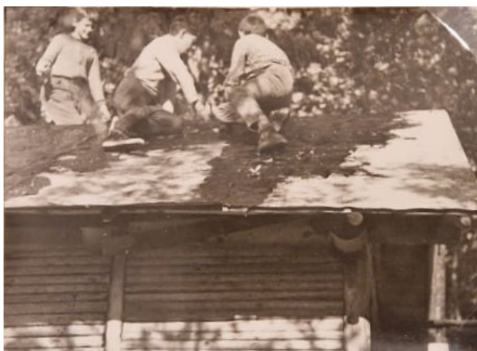
Obrázek č.16: Stavba klubovny ve Vrchotových Janovicích 343
