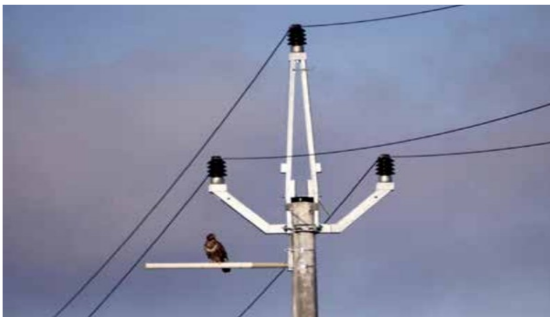
Obr.č.4: Stožár typu Pařát 3 s bidlem (zdroj: VÁCLAV HLAVÁČ, VLASTA ŠKORPÍKOVÁ, ZBYNĚK JANOŠKA, 2017. Na sloupech elektrického vedení stále hynou desetitisíce dravců. Časopis Ochrana přírody 2/2017. Dostupné z: https://www.casopis.ochranaprirody.cz/pece-o-prirodu-a-krajinu/na-sloupech-elektrickeho-vedeni-stale-hynou-desetitisice-dravcu/ )
