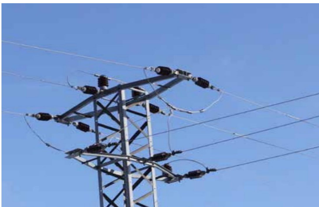
Obr.č.5: Odbočovací konstrukce (zdroj: VÁCLAV HLAVÁČ, VLASTA ŠKORPÍKOVÁ, ZBYNĚK JANOŠKA, 2017. Na sloupech elektrického vedení stále hynou desetitisíce dravců. Časopis Ochrana přírody 2/2017. Dostupné z: https://www.casopis.ochranaprirody.cz/pece-o-prirodu-a-krajinu/na-sloupech-elektrickeho-vedeni-stale-hynou-desetitisice-dravcu/ )
