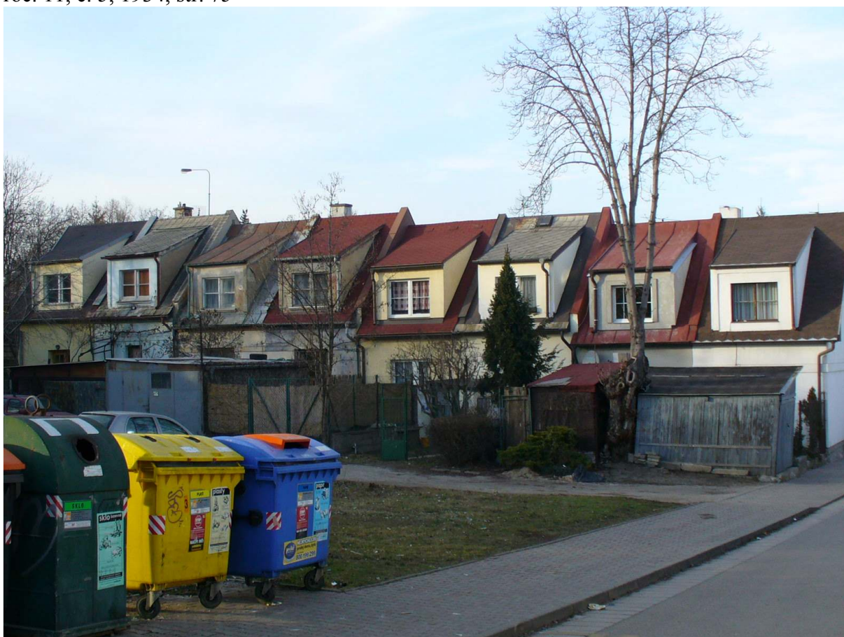
Dělnické rodinné domy tzv. sedmidomky v Praze Vršovicích, postavené v rámci snah města Praha o ozdravení bytové situace. Stav z roku 2007.
