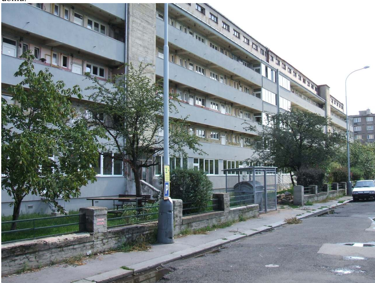
Pavlačový dům pražské obce, 1934. arch. F.A. Libra, J. Kan, Praha Holešovice, U městských domů. Stav z roku 2007.
