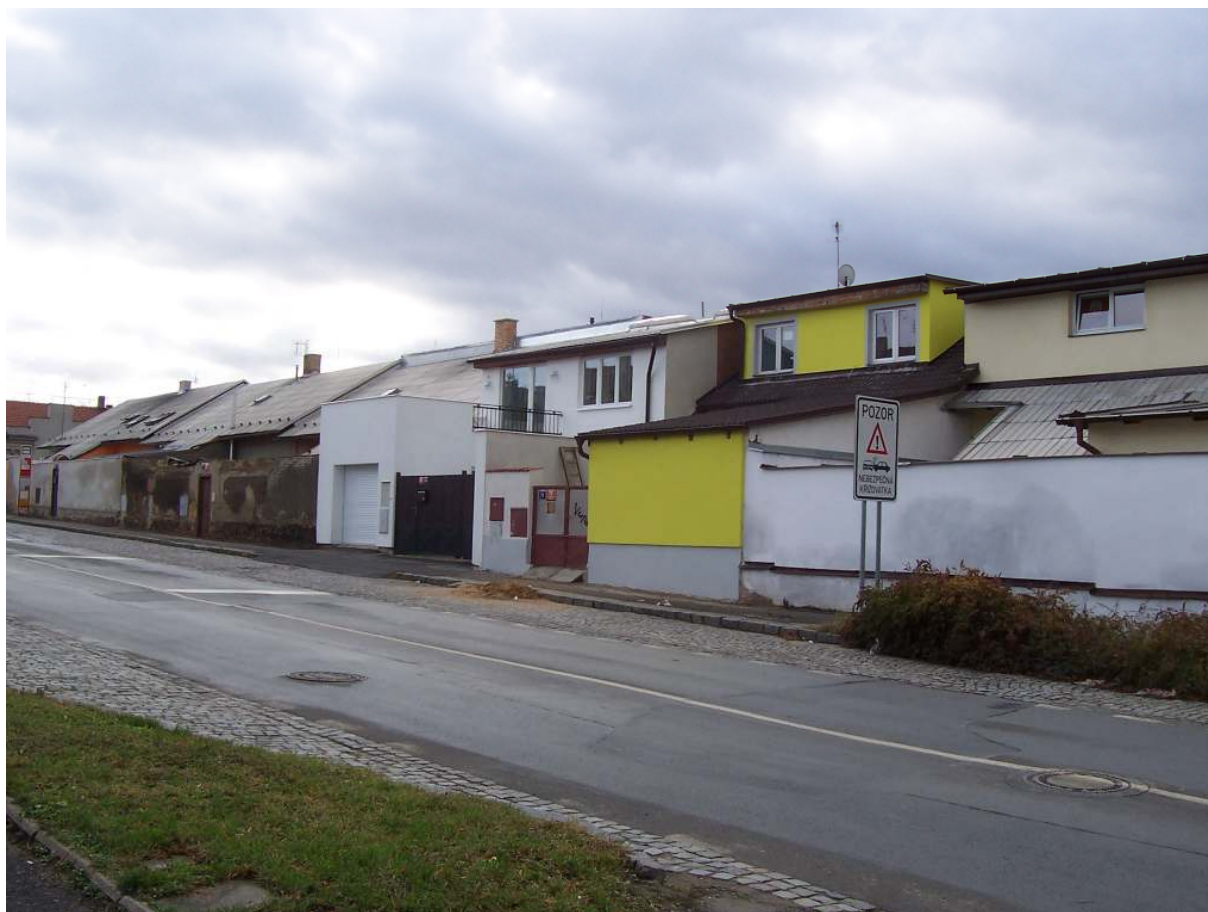
Dělnická kolonie cukrovaru Čakovice, Petříkova ulice, stav z roku 2007. Objekt kolonie narušen pozdějšími dostavbami.
