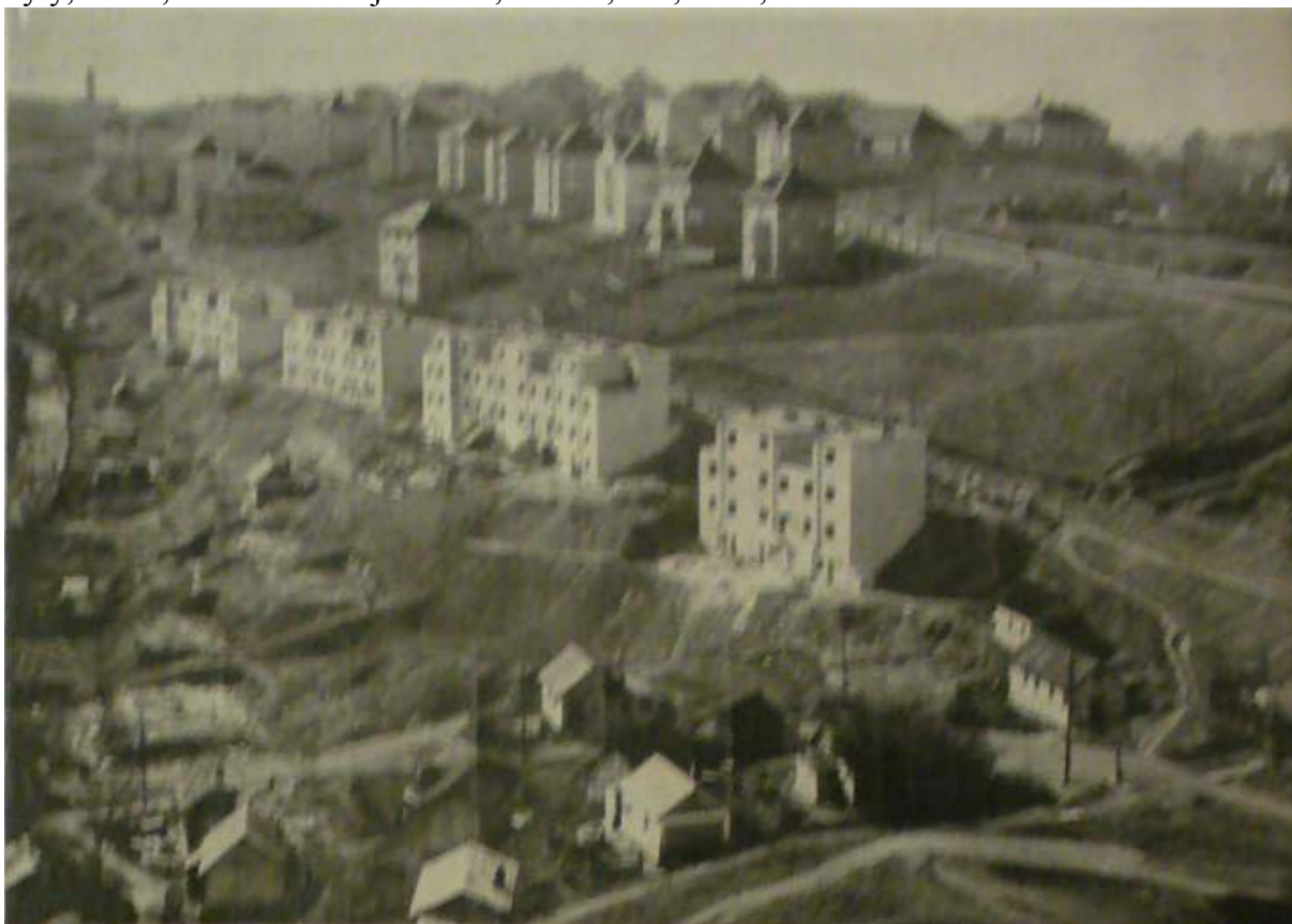
Praha 1934. Nahoře jsou vidět luxusní vily, ve středu se nacházejí nové řadové domy a dole je nouzová kolonie. Zdroj: Stavba, roč. 11, č. 5, 1934, str. 65
