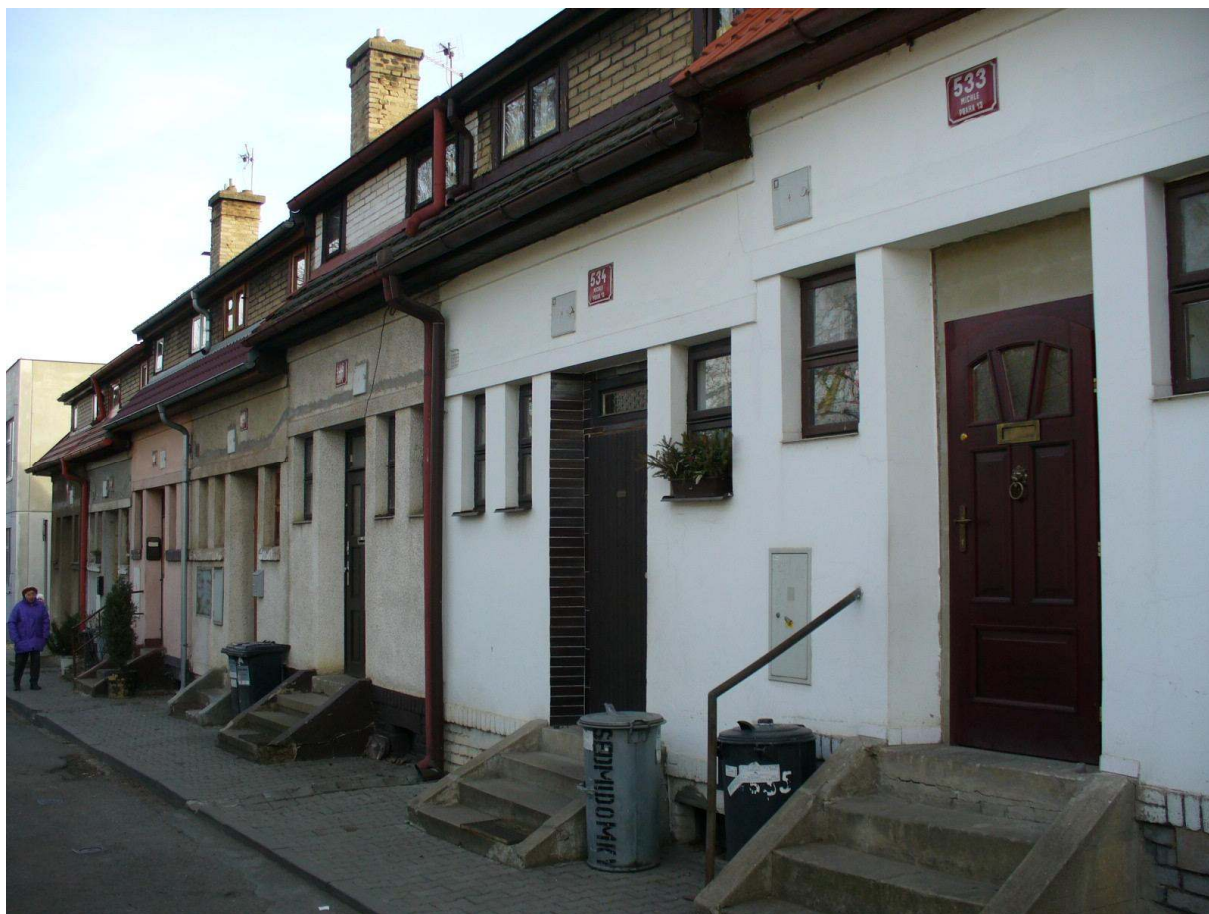
Tzv. Sedmidomky, Praha Vršovice, vstupní část. Stav z roku 2007.
