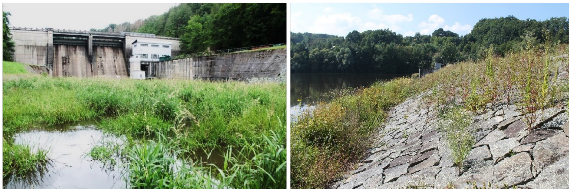
Obr. 8: Řeka pod hrází vodní nádrže Křižanovice (vlevo). Kamenná hráz Práčovské vodní nádrže (vpravo)
