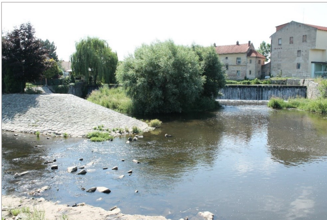
Obr. 5: Nemošice. Vlevo, mimo obrázek je jez hlavního koryta Chrudimky. Uprostřed obrázku se nachází jez od náhonu, pod ním je ostrov vzniklý z naplavenin. Vpravo nahoře budova mlýna.
