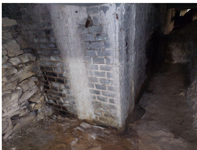
Obr. 13. Měřicí stanoviště zed' „u vchodu”. Vlastní foto autorky.
