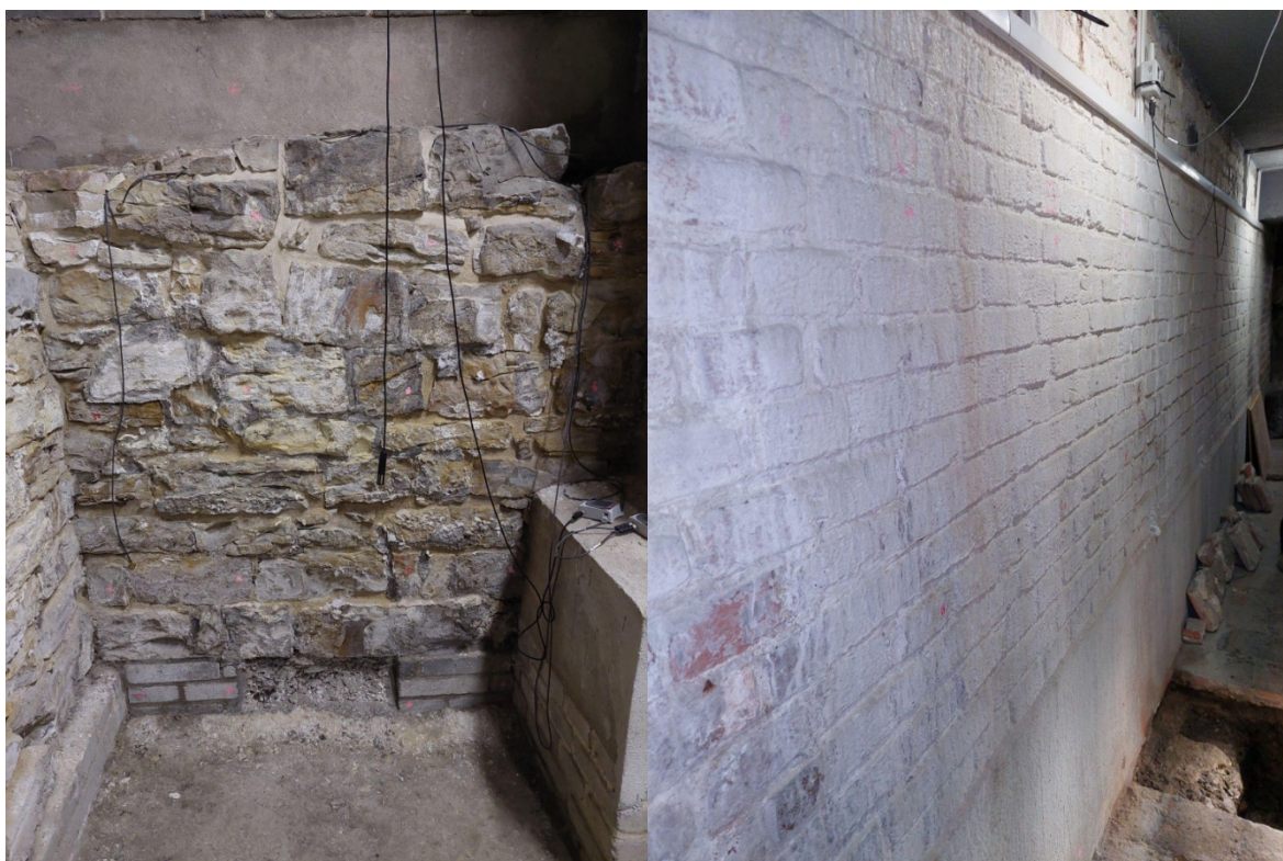
Obr. 12. Vlevo - měřicí stanoviště zed' „u šterku”. Vpravo - měřicí stanoviště zed' „sv. Bartoloměj” Vlastní fotografie autorky.
