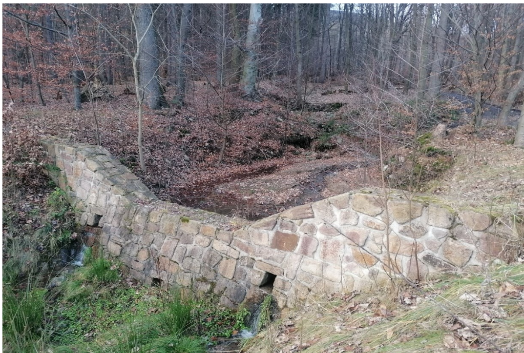
Obr. 30 – akumulovaný sediment v dešťové zdrži na Hajském potoce (fotografie autora)
