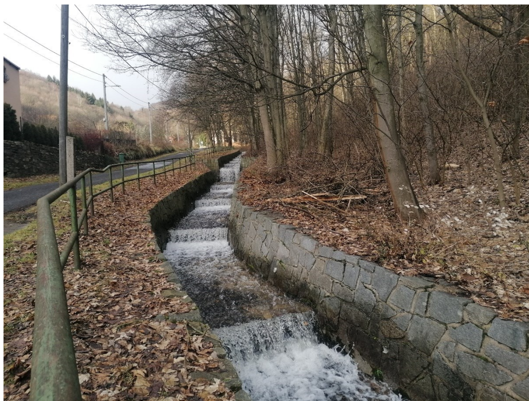
Obr. 31 – nepropustné opevnění celého koryta Oseckého potoka (fotografie autora)
