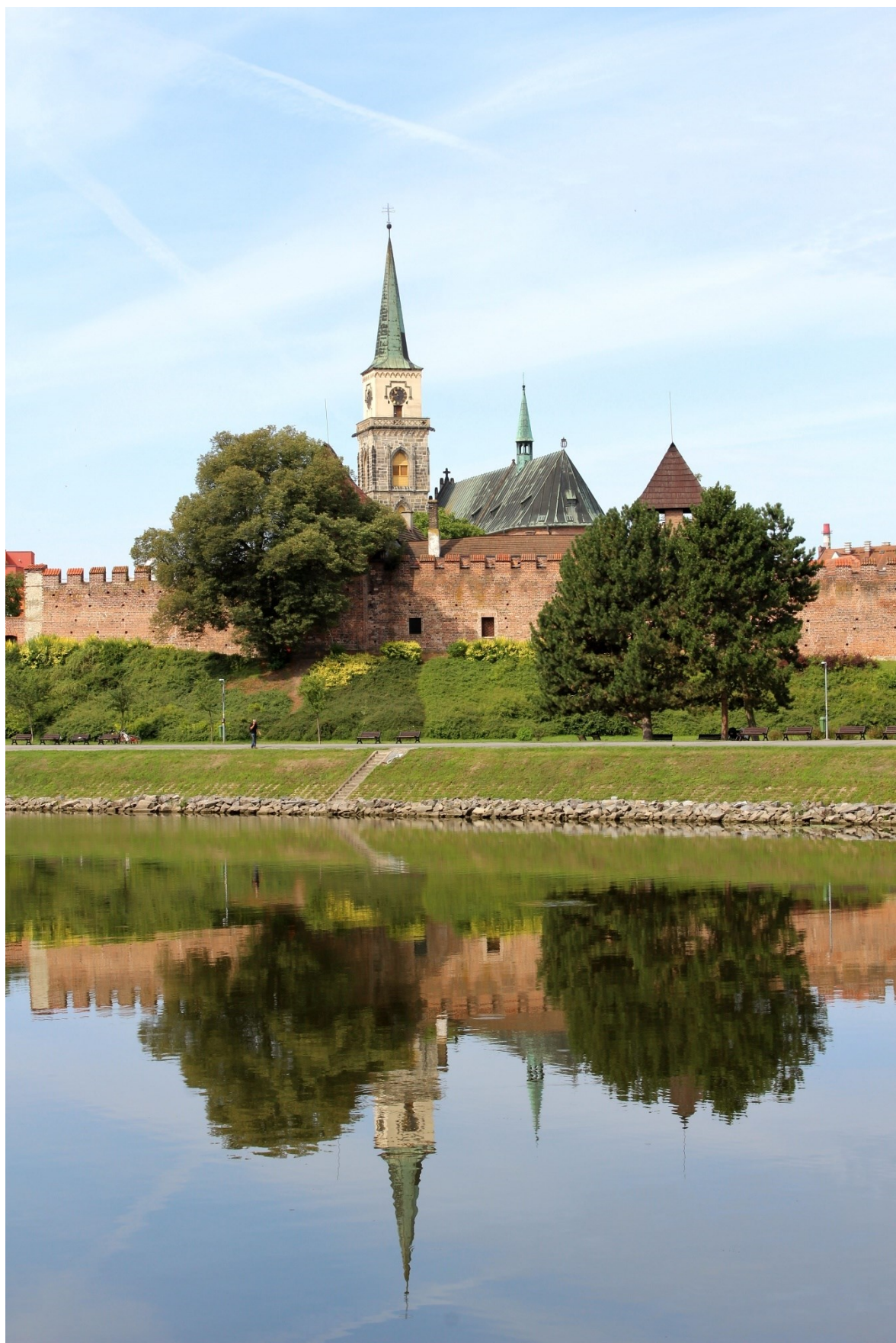
158. Nymburk, pohled na hradby u starého děkanství přes regulovaný úsek Labe.
