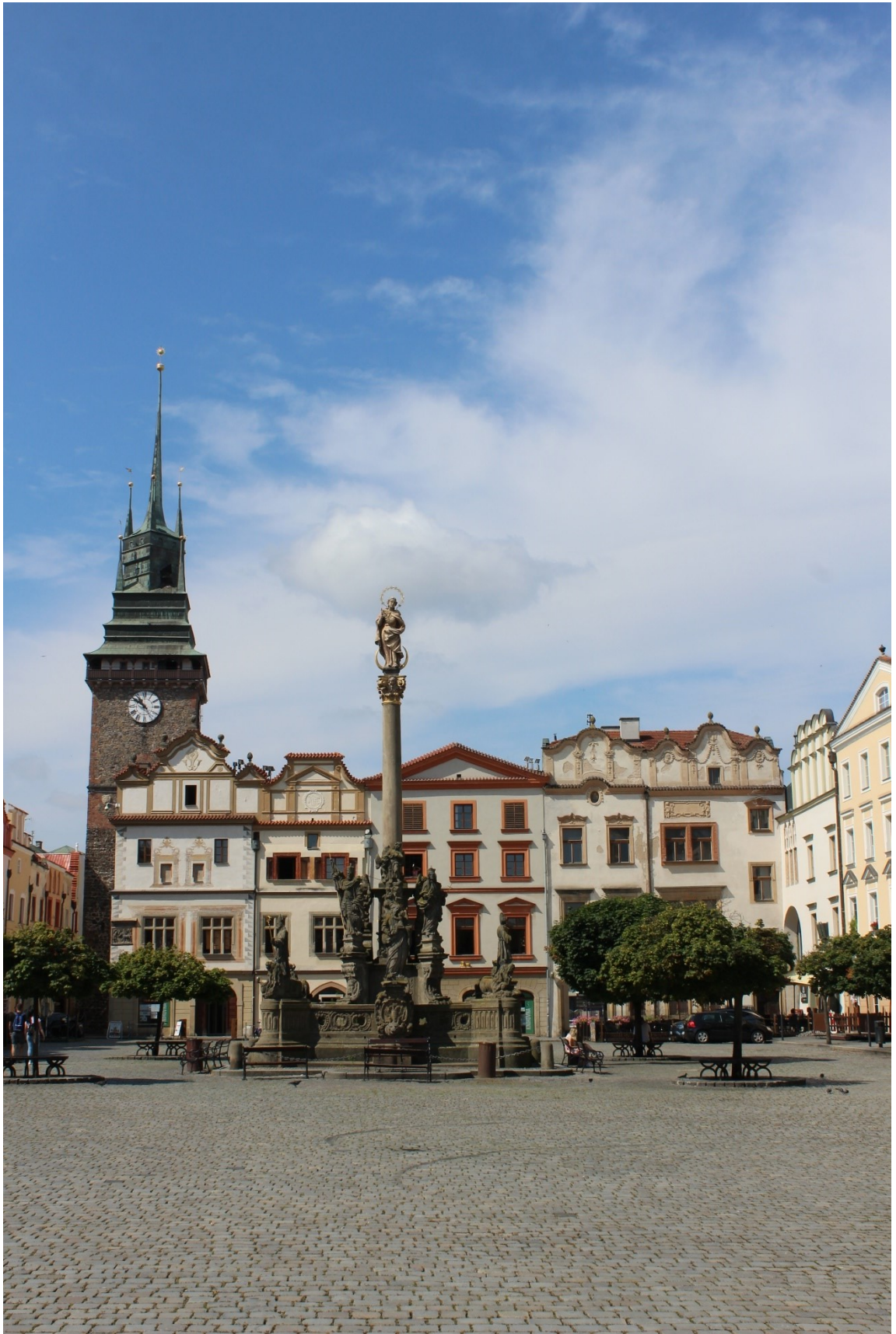
235. Pardubice, pohled na západní frontu náměstí s novostavbou domů čp. 80 a 81, 1909, Bóža Dvořák.
