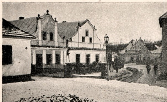
Z PELHŘIMOVA: LEPENKOVÉ STŘECHY ZA STARÝMI VÝSTAV- NÝMI ŠTÍTY JSOU NEDŮSTOJNĚ.
