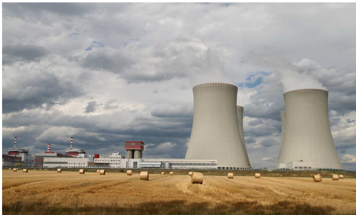
Jaderná elektrárna Temelín v „lepší světlo“.
