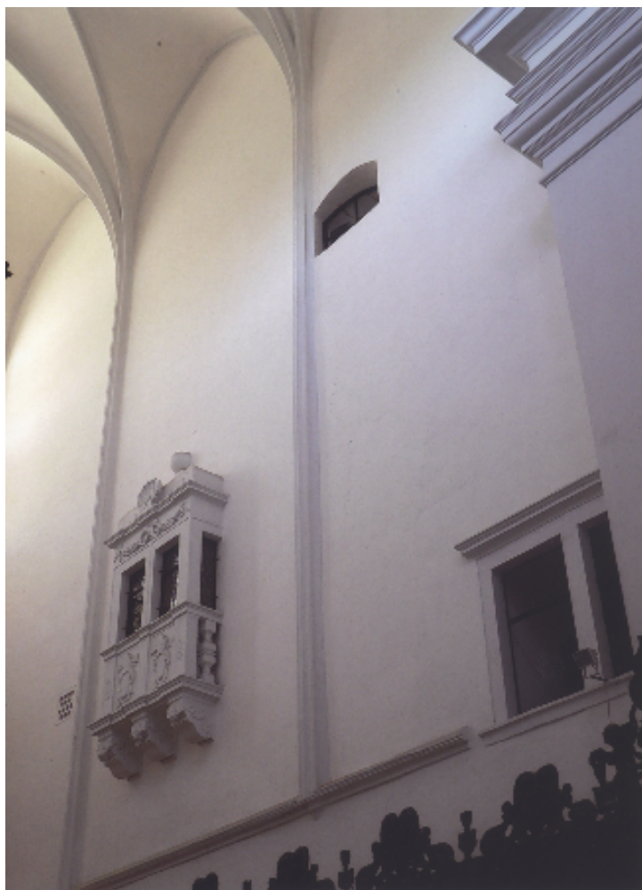
Obr. 18. Premonstrátský klášter v Loučeň. Kostel Panny Marie a sv. Václava. Pohled na jižní stranu chóru. Po pravé straně dochována barokní oratoř. V levé střední části umístěn renesanční arkýř z původní gotické empory. Úplně vlevo vedle přípory zřetelný starší průhled do lodi. V horní části se nachází okno, nalézající se v místech původního portálu, který ústil na můstek vedoucí do severní přístavby.
