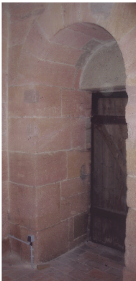
Obr. 3. Kostel sv. Jakuba ve Vroutku u Podbořan. Vstup na emporu se závorou.
