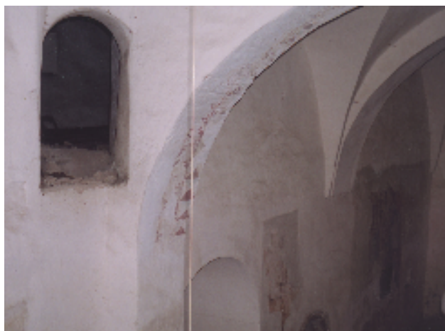
Obr. 17. Kostel sv. Anny v Příbyslavicích u Třebíče. Pohled na portálek, vedoucí z lodi do útočištné prostory nad sakristií. Vchod bylo možno před případnými útočníky zajistit zevnitř závorou.
