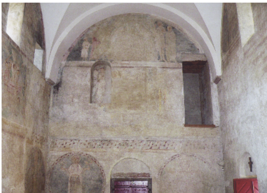
Obr. 10. Kostel sv. Klimenta ve Staré Boleslavi. Pohled na odstraněnou dřevěnou tribunu. Po pravé straně bílý pás vymezuje původní schodiště do lodi.
