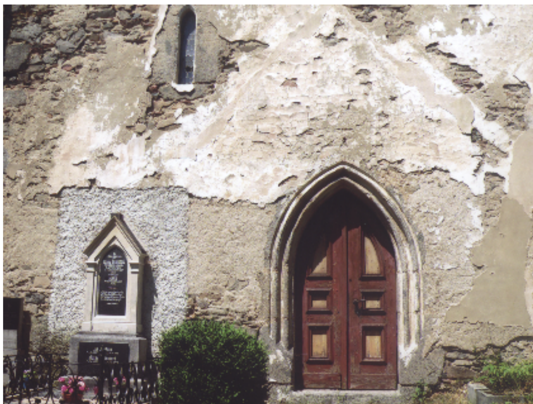
Obr. 12. Kostel sv. Kateřiny v Chrástu nad Sázavou. Pohled od jihu. V levé horní části dochováno původní okénko na tribunu.
