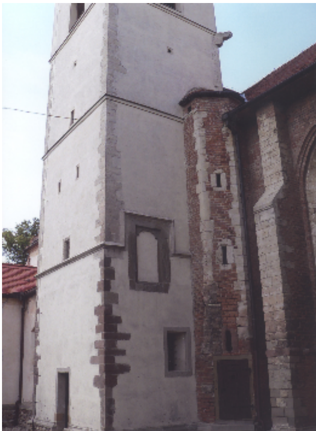
Obr. 22. Kostel sv. Markéty v Loděnici u Znojma. Celkový pohled od jihovýchodu. V prvním patře dochován portál, vedoucí na původní emporu. Točité schodiště spojovalo interiér s kaplí ve druhém patře, sakristií a zároveň kryptou.
