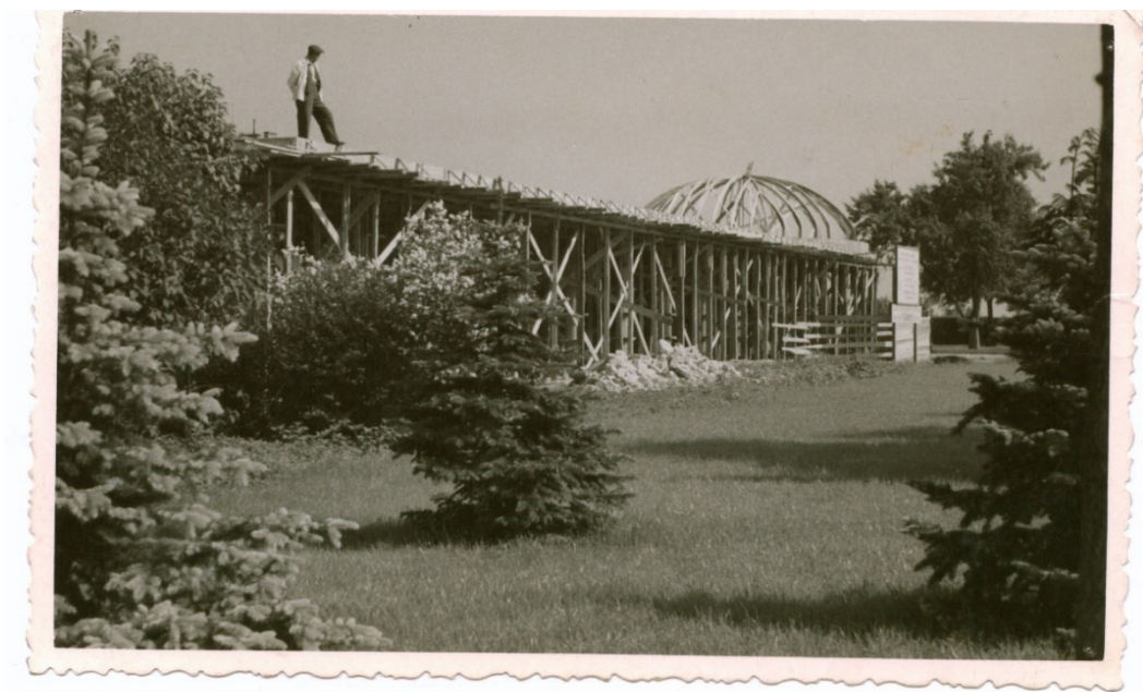
Příloha 7: Stavba kolonády v roce 1938
