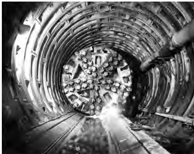
Obr. 9 Štít metody TŠČb (upraveno) – vlevo (zdroj: Horák (2007)), názorná ukázka - vpravo (zdroj: www.4stav.cz )
