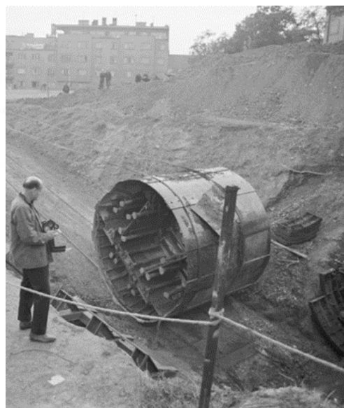
Obr. 8 Schéma nemechanizovaného štítu (upraveno) – vlevo (zdroj: Barták (2014)), názorná ukázka – vpravo (zdroj: www.reflex.cz)
