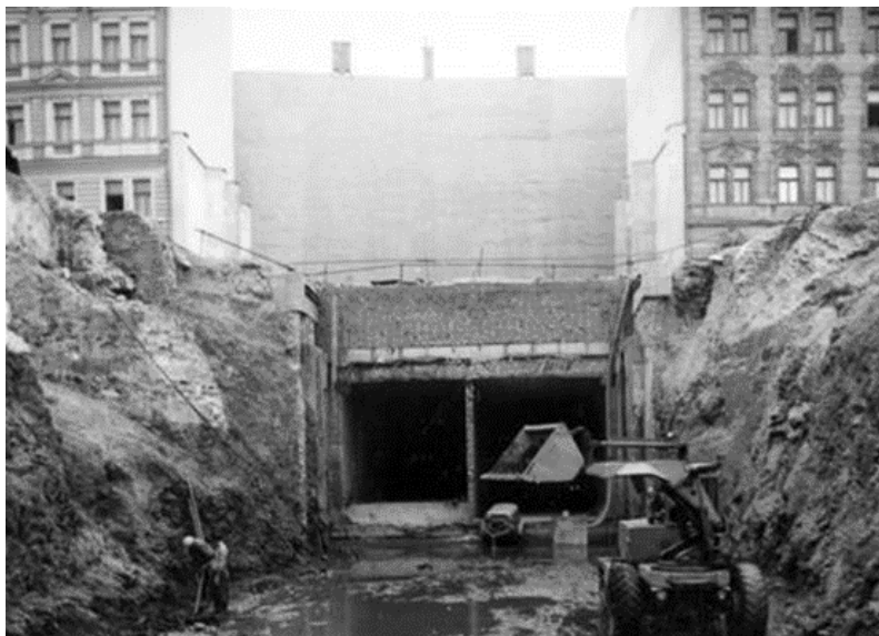
Obr. 4 Podzemní stěny (upraveno) – vlevo (zdroj: Zemánek (2020)), názorná ukázka - vpravo (zdroj: www.idnes.cz )
