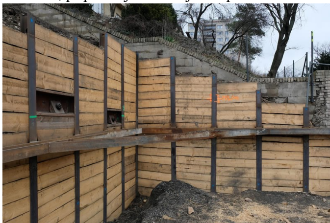
Obr. 5 Záporové pažení (upraveno) – vlevo (zdroj:www.fine.cz) , názorná ukázka - vpravo (zdroj:www.cenekajezek.cz )
