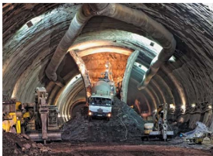
Obr. 7 Schéma metody NRTM - vlevo (zdroj: Barták, Pruška (2011)), názorná ukázka - vpravo (zdroj: Mosler et al. (2019))
