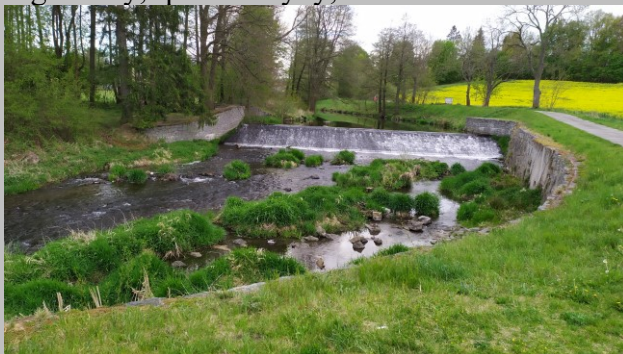
Obr. 15: Jez nad čistírnou odpadních vod ve Volyňi. Fotografie autora.
