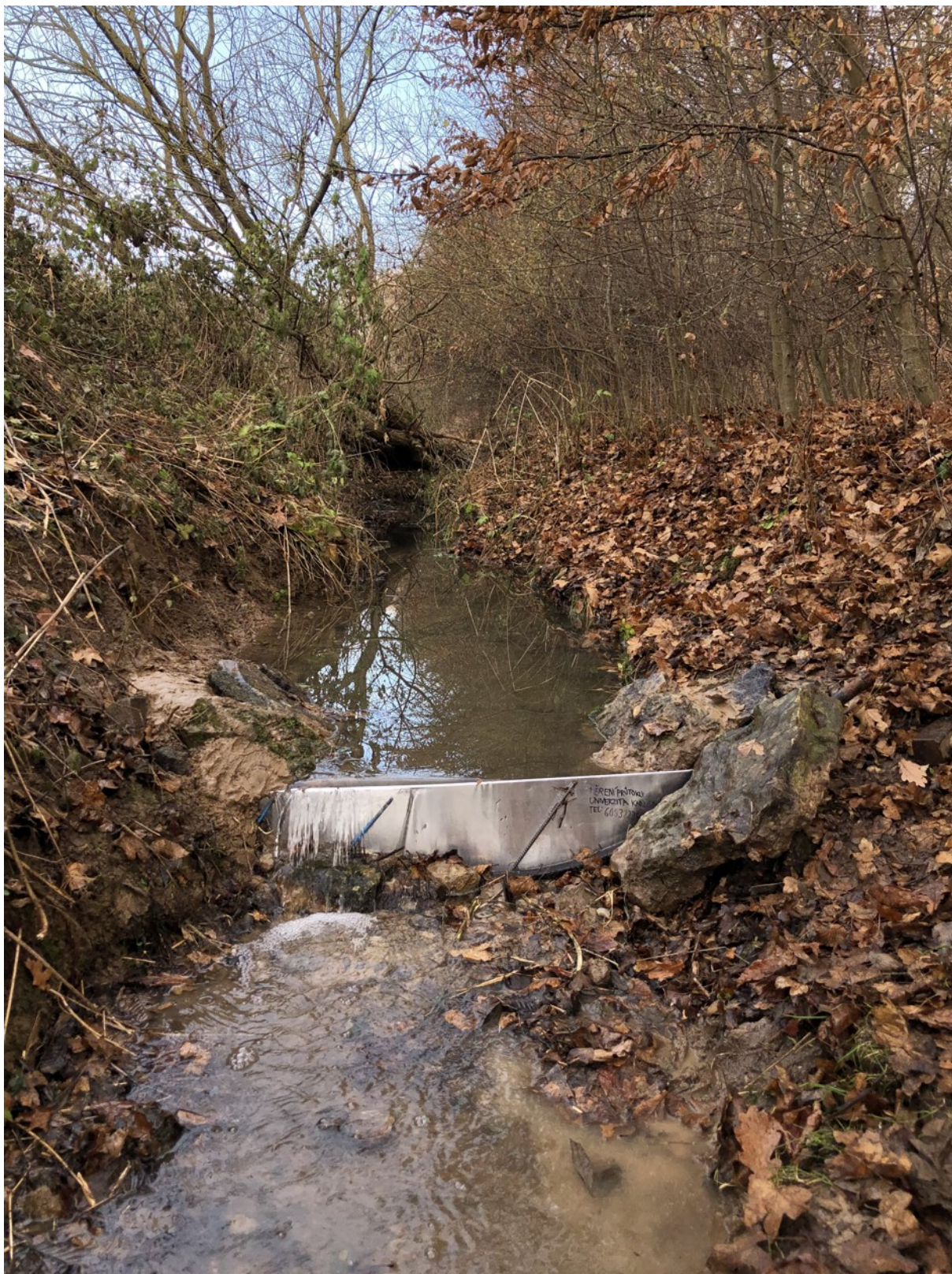
Obr. 5.2 - konstrukce přelivu v profilu A. Foto: autor.
