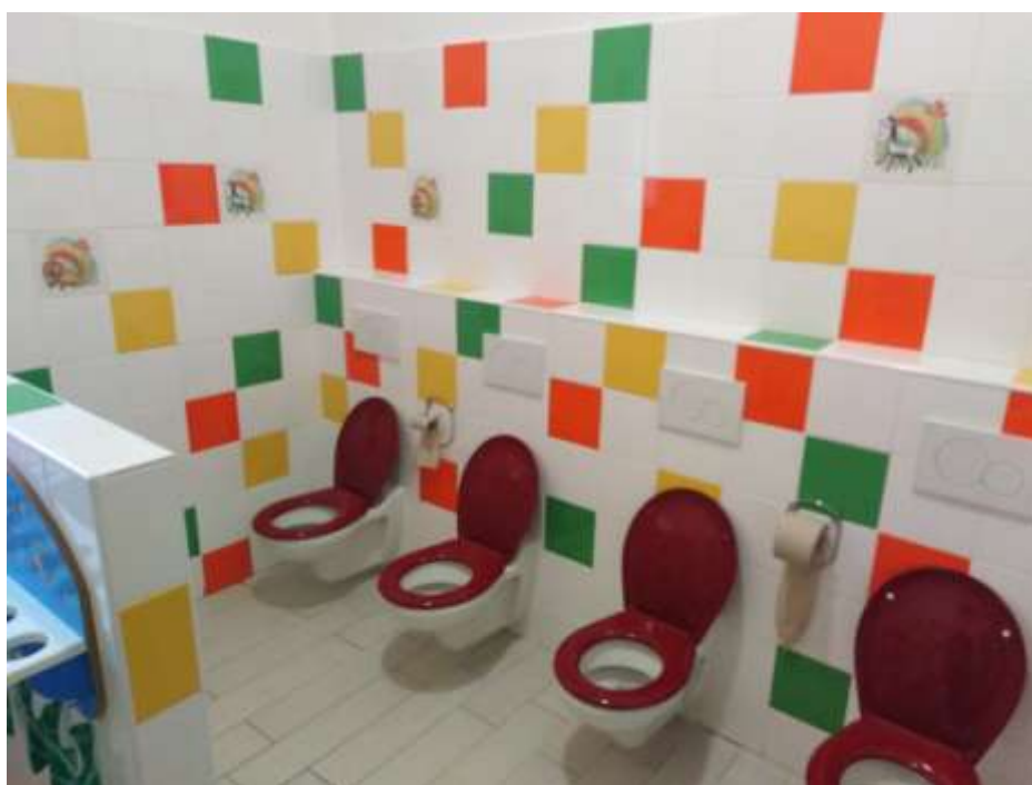
Obrázek 11. Toalety – nově zrekonstruované
