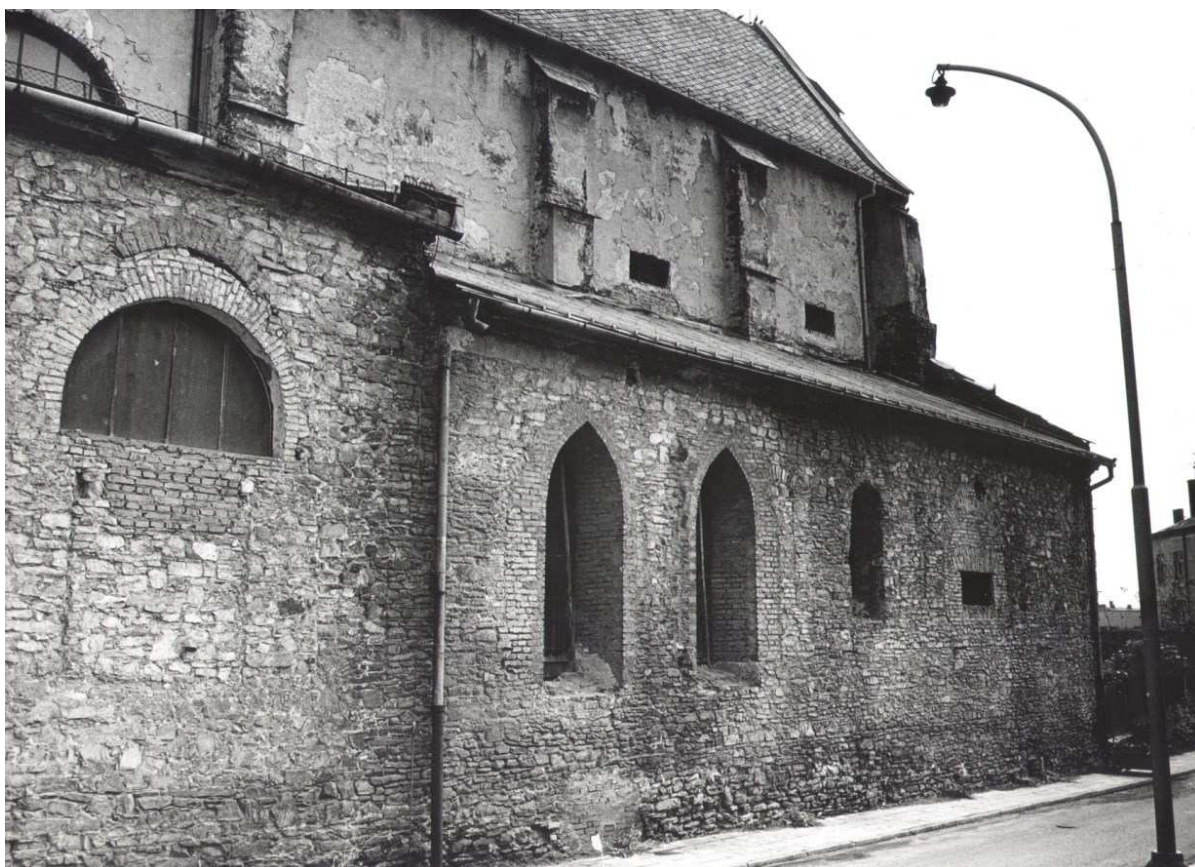
Obr. 26: Opava, kostel sv. Václava, jižní zeď kaple sv. Dominika s polokruhovitě zaklenutým okénkem (70. léta 20. století, fotoarchiv Okresního stavebního podniku).
