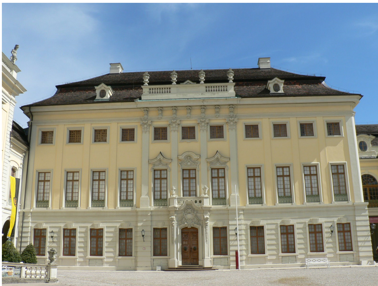
2.7 Vázy na střešní balustrádě „Riesenburg“. Zámek Ludwigsburg, 1714
