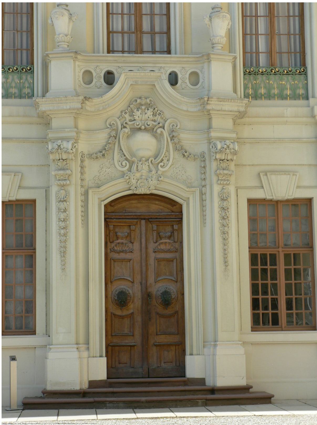
2.5.1 Vyřezávané dveře „Ordensbau“ – celek. Zámek Ludwigsburg, 1712
