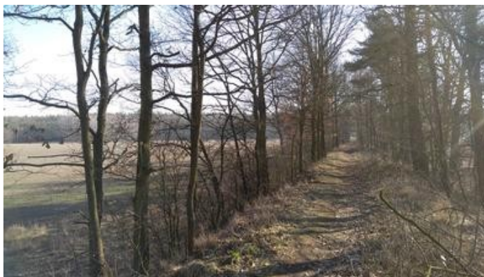
Obrázek 34: Hráz rybníka Rozkoš nazývaná Pernštejská hráze (zdroj: Černý, M. 2019, online).
