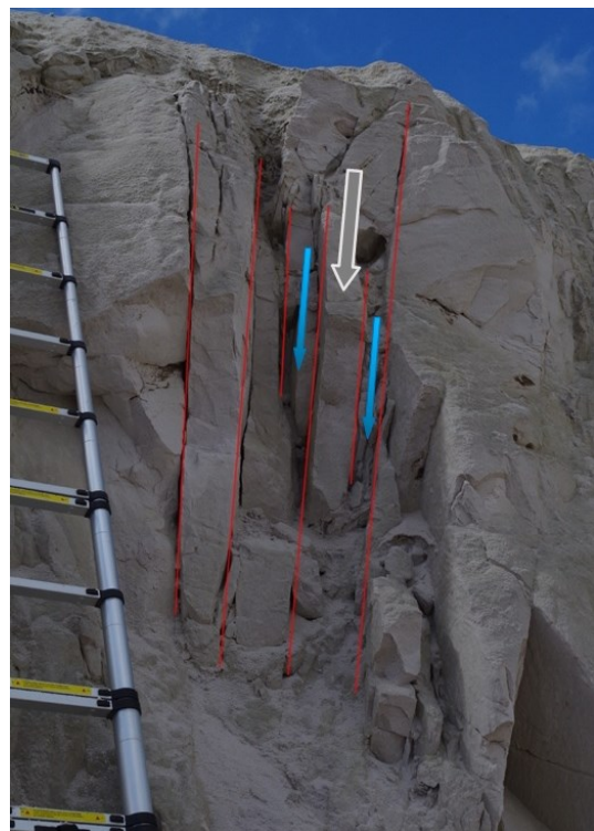
Obrázek 5.17: Puklinová zóna s vyznačenými erozními mechanismy – modrá šipka značí vymývání, šedá šipka značí řícení. Červeně jsou vyznačeny hlavní pukliny.
